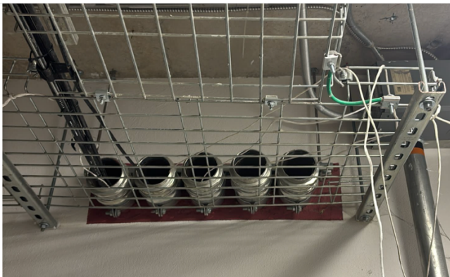
Sótano torre B
